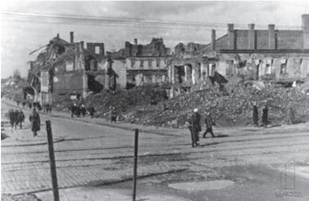
Вид на разрушенные жилые дома по ул. Ленинской в г. Минске. 1944 г.
